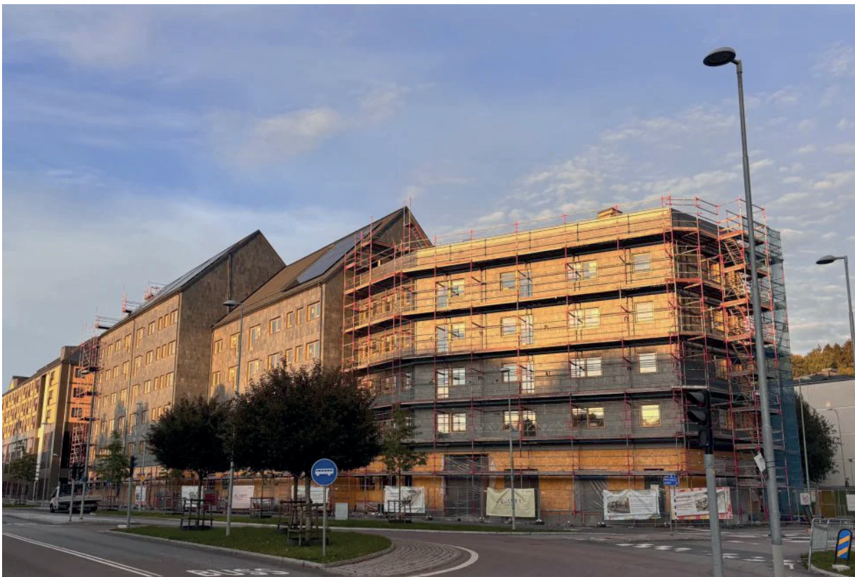
Fasaden med återbrukat skiffer på Kvarteret Omställningen längs Litteraturgatan börjar bli färdig. Foto: Selma stad
